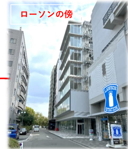
ローソンの傍 豊中共創棟A・B (旧 文理融合型研究棟)
